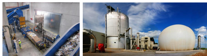
Figura 20 – TMB – segregação das embalagens e biodigestão seca dos orgânicos
