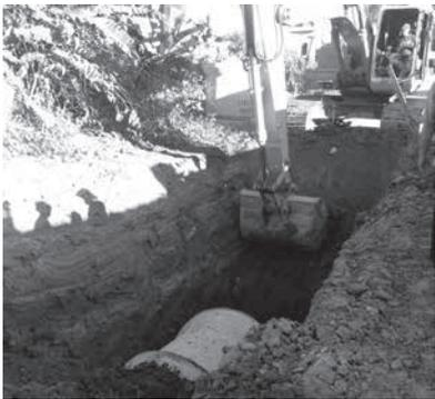
realizada devido à antiga tubulação de tubo amíaco que apodreceu, cedendo o terreno e fechando a passagem das águas
