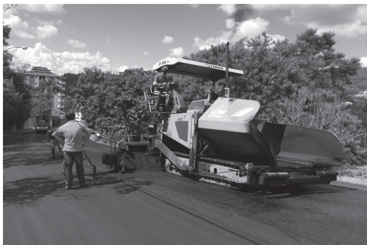
- Rua Amparo (parcial) - Centro, área de 2.272m 2 ;
