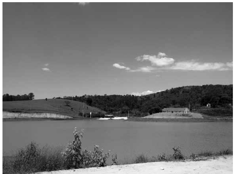
- 2ª etapa de obras do Parque Ecológico Santa Lídia
